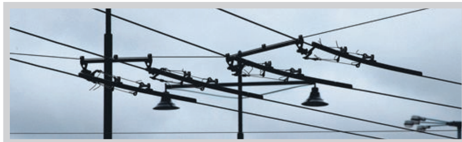
Słupy trakcyjne, trakcyjno-oświetleniowe oraz sieć zostały wymienione lub odnowione. Uwagę przyciągają stylizowane oprawy oświetleniowe
