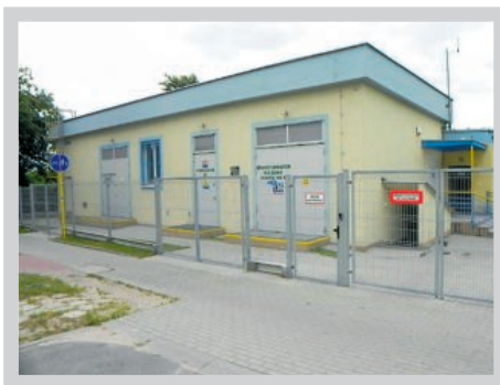
Podstacja zasilająca Redłowo wraz z budynkiem CDMIR
